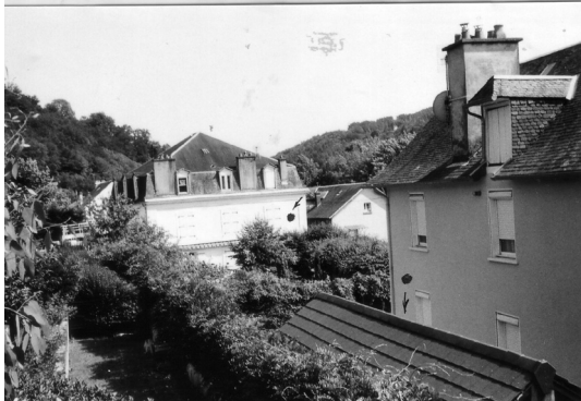
Vue de l'ancienne gendarmerie, à gauche et du siège du B.R.O, à droite, côté jardin, permettant aux membres de s'échapper rapidement
