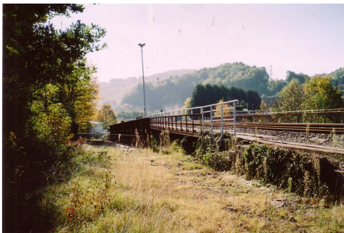
Ponts de fer, direction Laguenne ((bas), direction Brive (haut et à droite), direction Ussel (à gauche). Au dessus des arbres, à droite le pylône de la ligne de Marèges (1)
