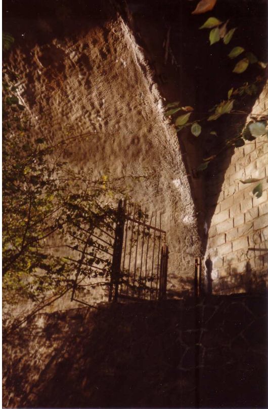
Sous les ponts des lignes de chemin de fer du P.O.C. et du PO, le passage est étroit pour se rendre à l'usine de confitures VALADE par un sentier.(1)
